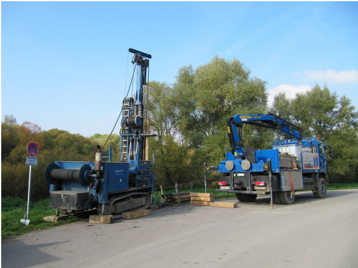
Baugrunduntersuchungen bei Hochwasserschutz Regensburg im Abschnitt F, Gallingskofen (Quelle: WWA Regensburg)
