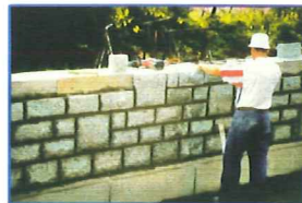
Vormauerung mit naturraumbezogenen Granitsteinen im unregelmäßigen Verbund
