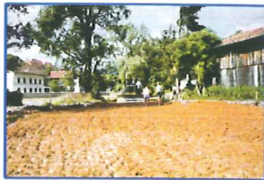
Vorbereitung der Deichauflandfläche durch Bodenaustausch, falls erforderlich, und mehrfaches Verdichten.
