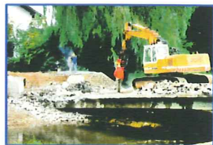
Abrißarbeiten an der alten Brücke im Sommer 1995
