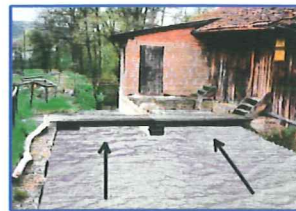
Ehemaliges Triebwerk in Oberwasser, links Leerschuf, rechts Turbineneinlauf
