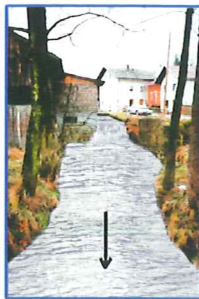
Unterwassergraben mit Leerschufüberlauf
