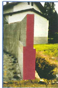
Hochziehen der Stahlbetonmauer mit Aussparungen für die Granitsteinvermauerung
