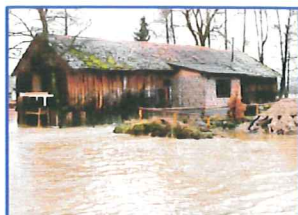
altes Sägewerk beim Hochwasser 1993
