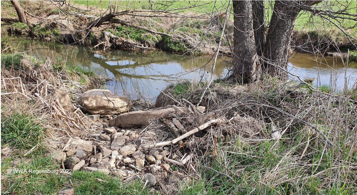
Abbildung 2: naturnaher Abschnitt nördlich Weiding. Uferanbrüche und Geländemulden werden dennoch mit Steinschüttungen gefüllt.
