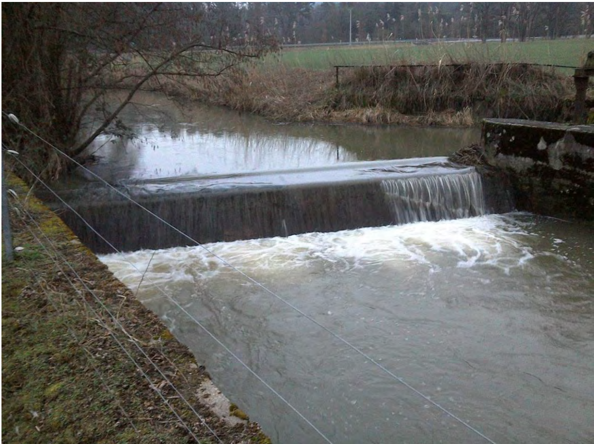
Abb. 1: Thema Durchgängigkeit (Wehr zur Breitenfurtermühle bei Pollanten): Hier ist kein Weiterkommen für Fische und andere Gewässerorganismen möglich
