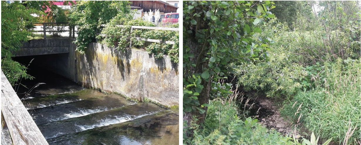
Abb. 2: Verrohrter Freybach in Neukirchen b. Hl. Blut (li) und nahezu trockenes Flussbett bei Penzenmühle (re) (Fotos: Bär, 2020).
