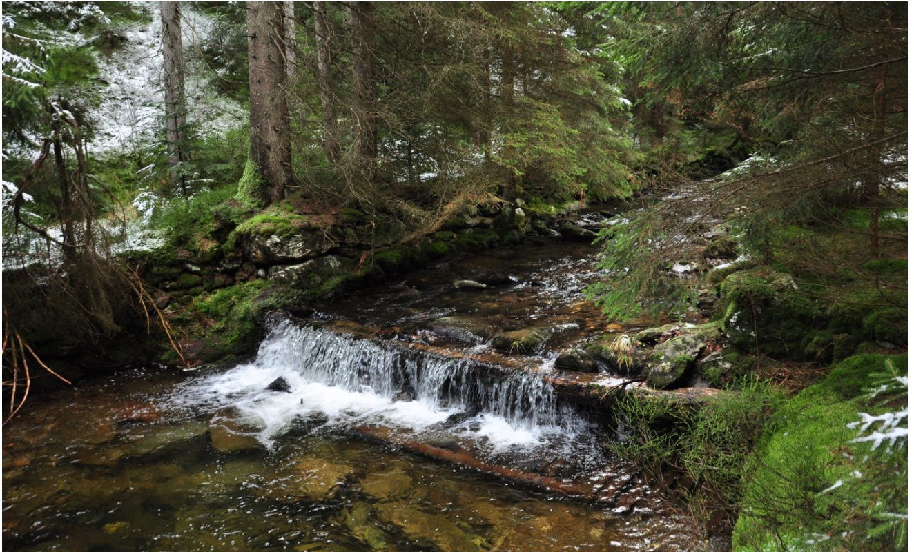
Absturzbauwerk am Weißen Regen
