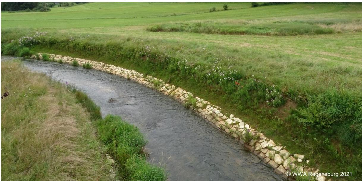
*Durch Uferverbau ist die eigendynamische Entwicklung unterbunden, wie hier unterhalb Biermühle.*
