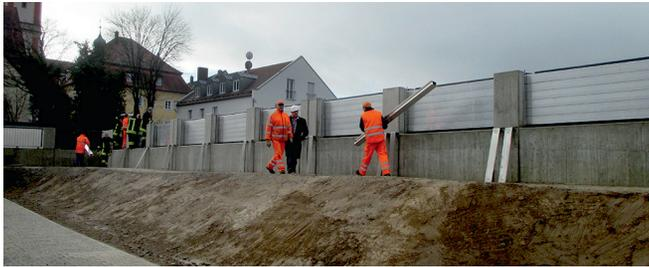
„Probe“-Aufbau mobiler Elemente
