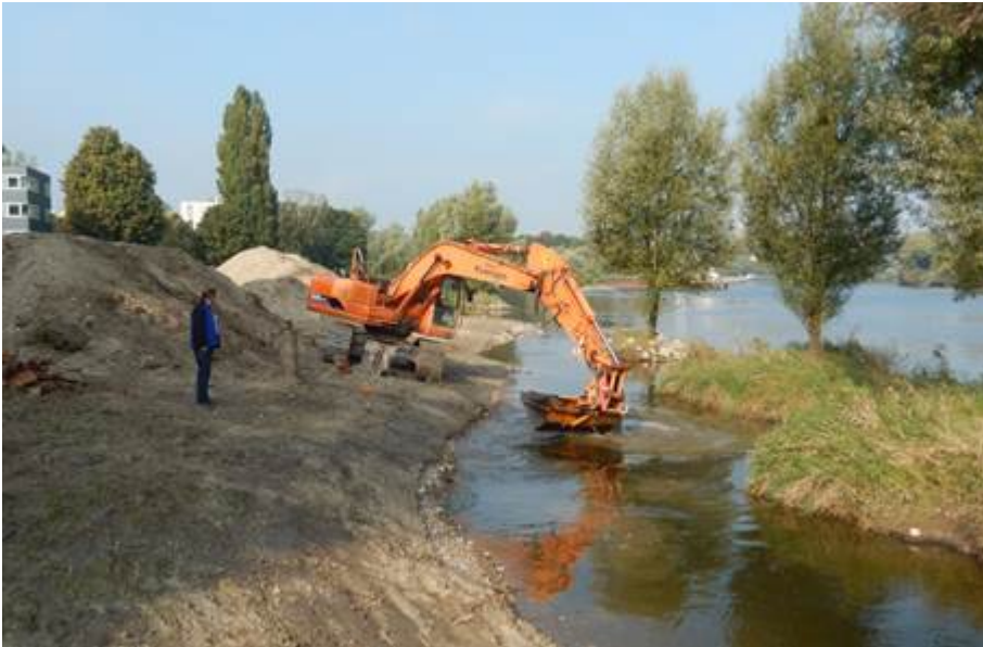
Bagger beim Ausbaggern der Flachwasserzone, im Hintergrund abgetragenes Material
