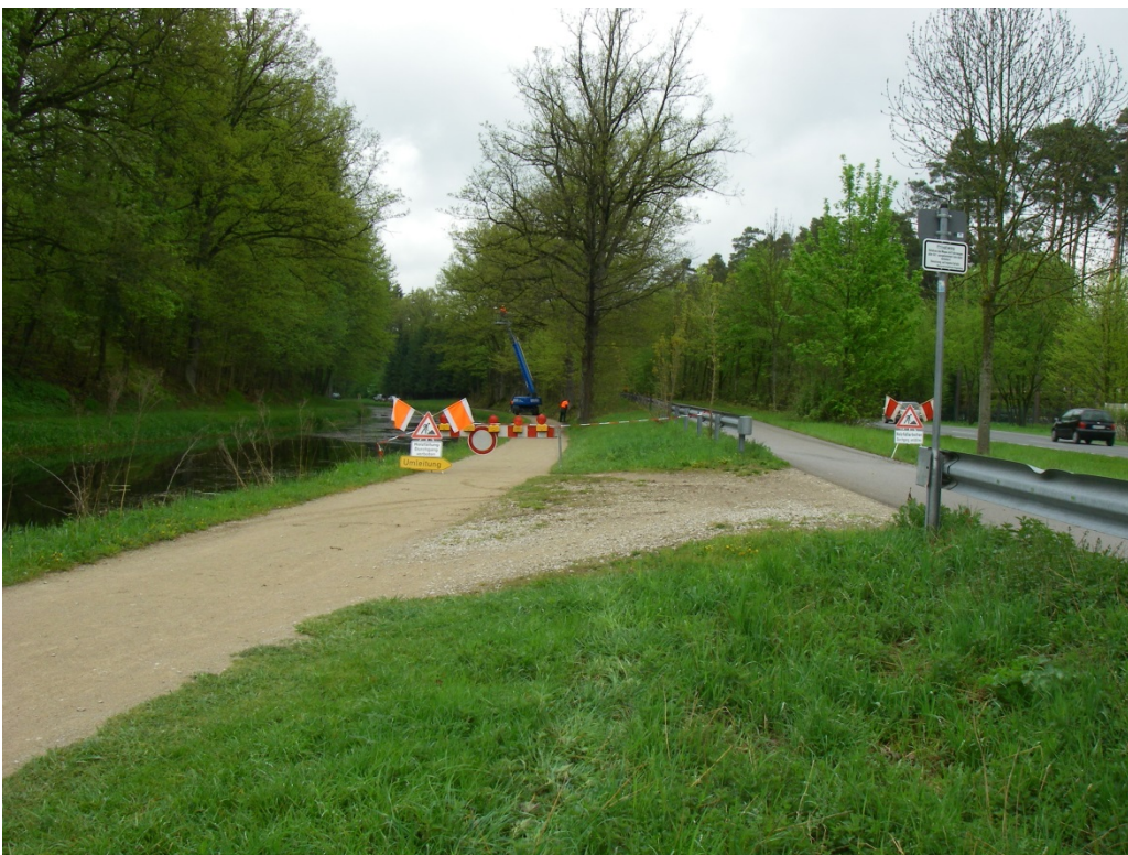
Baumpflegearbeiten mit Hubsteiger am Alten Kanal
