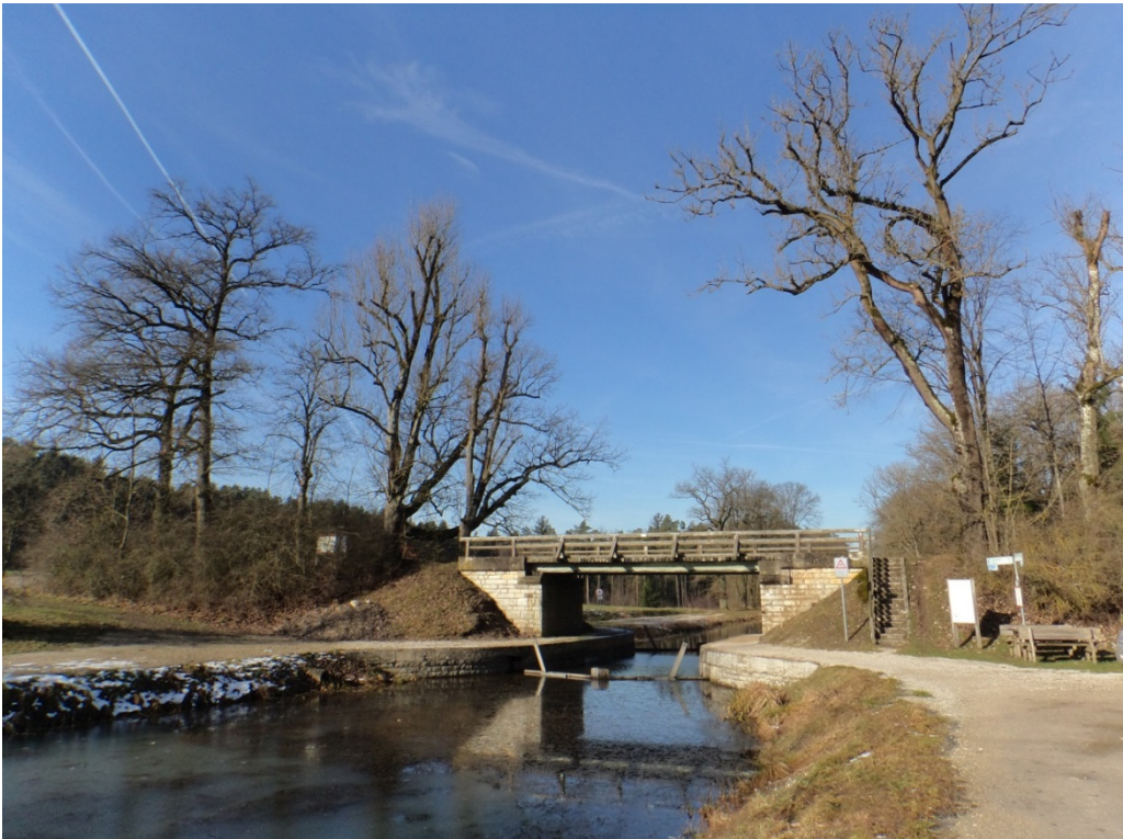
Brücke Loderbach am Ludwig-Donau-Main-Kanal in Berg bei Neumarkt i.d.OPf.
