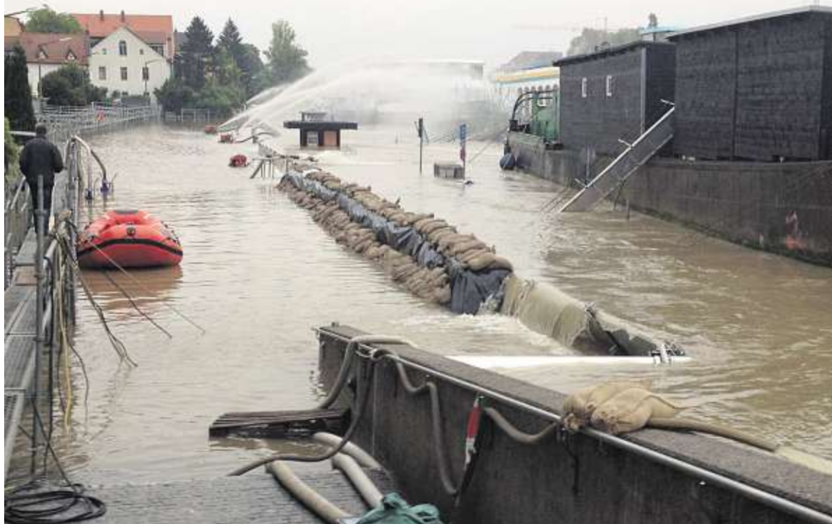
Die Wertstraße am Dienstag: Hier hielt der Wall aus mobilen Schutzelementen und Sandsäcken den Wassermassen nicht stand. Für hochwassergeschädigte Anlieger versprach OB Schaidinger gestern Soforthilfen. Foto: Lex
