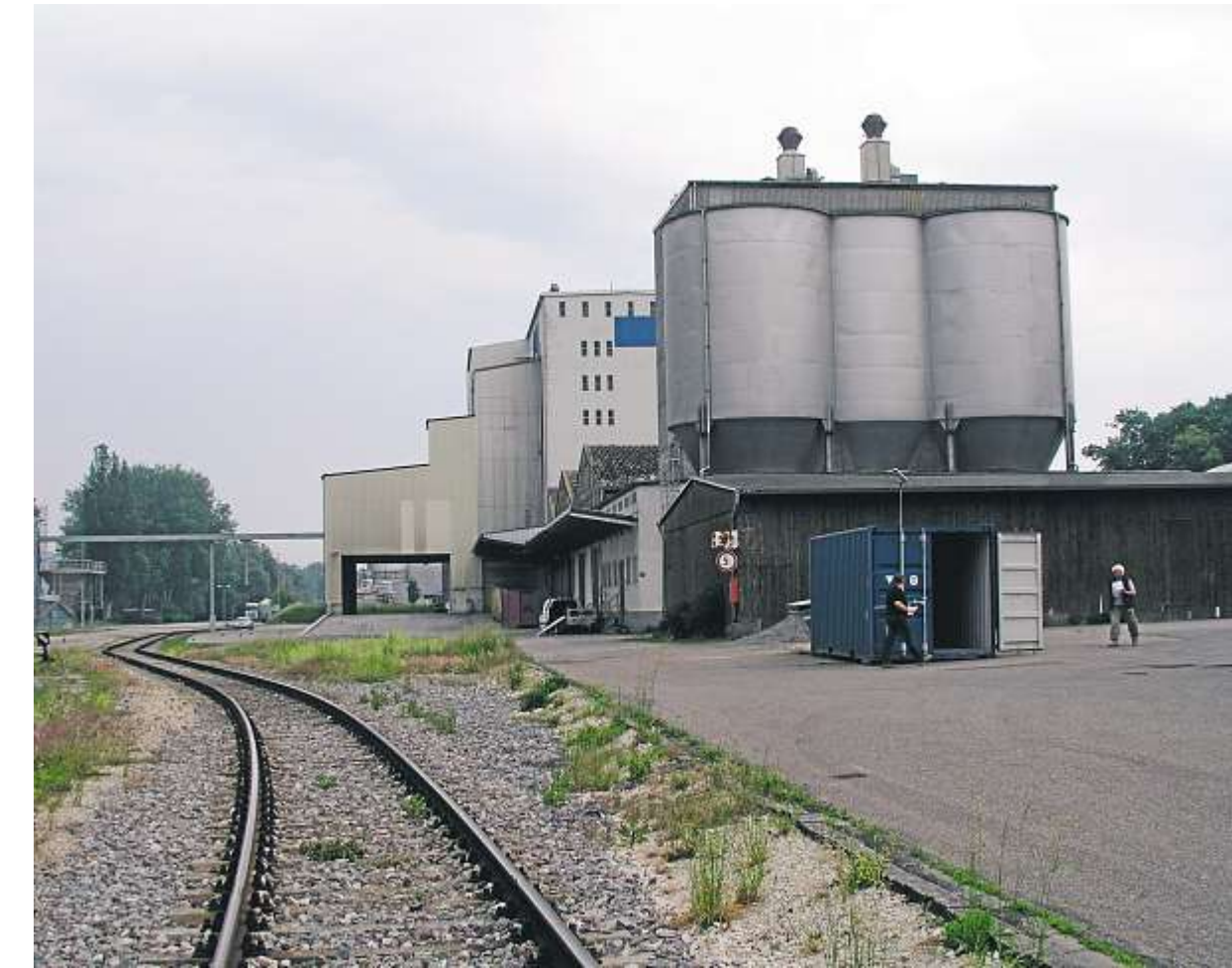
Ab Donaulände/Budapester Straße wird die Schutzmauer entlang des Futtermittelmischwerks geführt.
