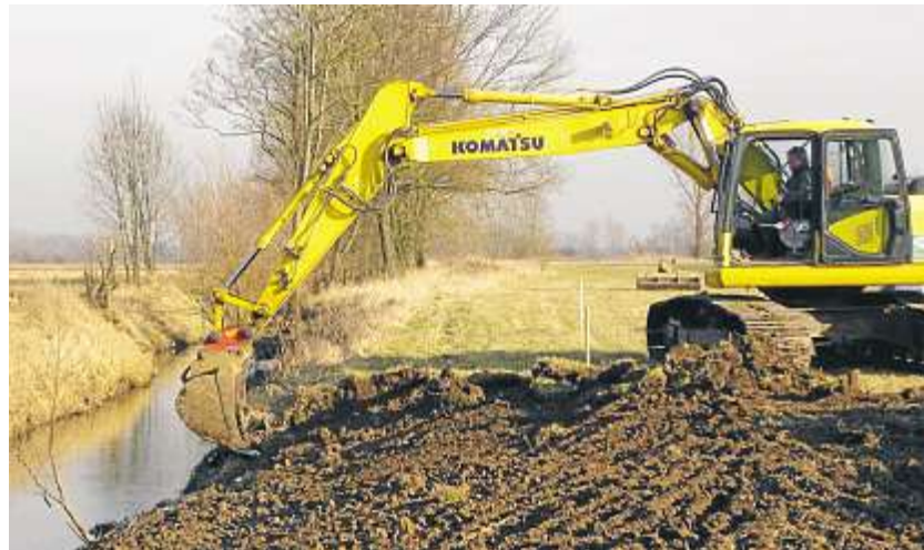
Ein Bagger hebt Erdreich aus. Das Bachufer ist zu hoch und zu steil. So erst ist im Frühjahr eine Bepflanzung mit einheimischen Bäumen möglich.
