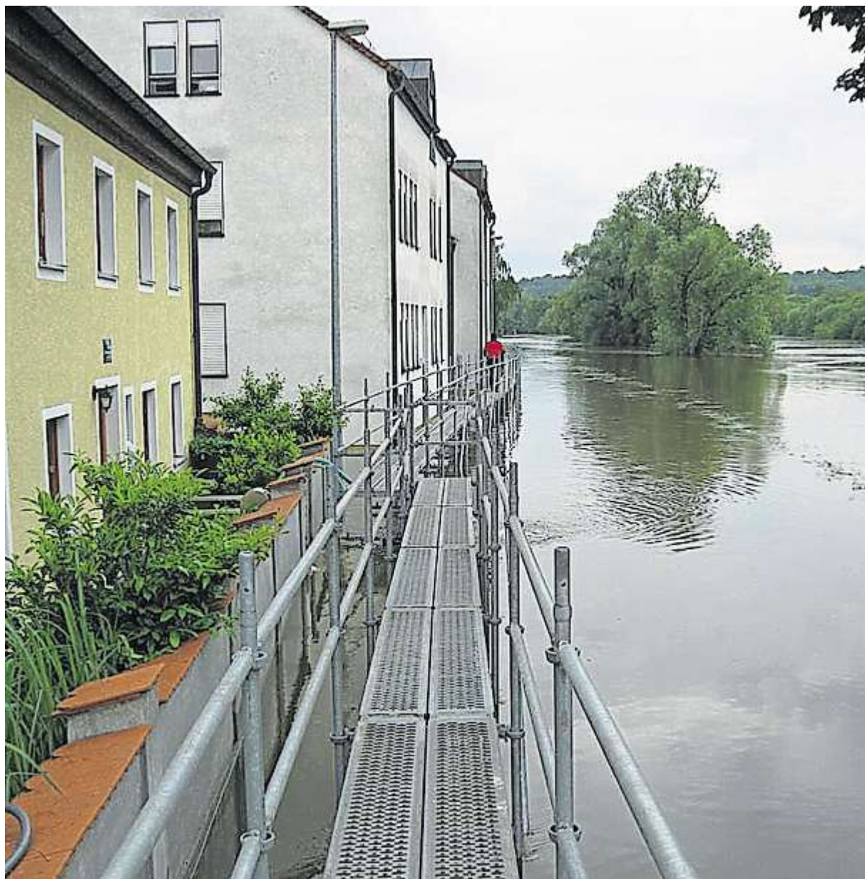
Einen Behelfssteg, so wie hier bei der Flut im Juni, werden die Anwohner des Regens im Bereich Sallern/Gallingkofen in ein paar Jahren nicht mehr benötigen: Der Hochwasserschutz soll bald kommen. Foto: Wasserwirtschaftsamt
