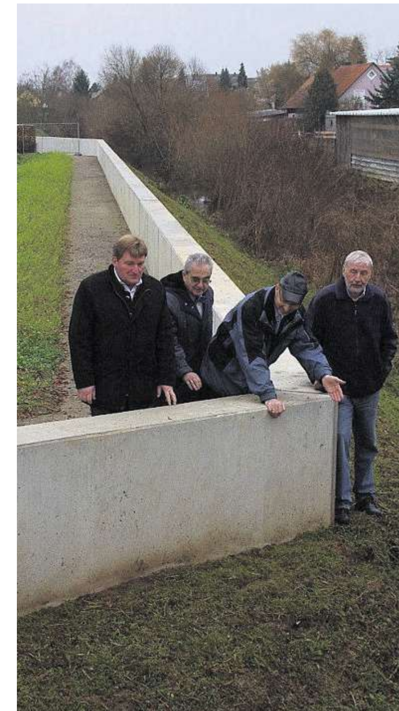
„Bombenfest“: Bürgermeister Franz Kröninger, Dr.-Ing. Albert Heinzlmeir, Bauoberrat Alfons Lerch und Dr.-Ing. Harro Lührmann nehmen die Hochwasserschutzmauer unter die Lupe.
