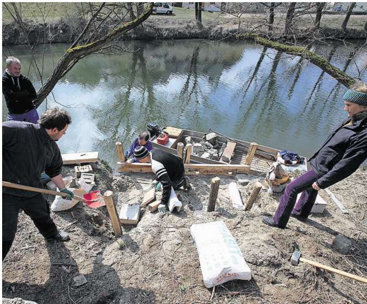
Mit vereinten Kräften entsteht die künstliche Brutwand des Eisvogels.
