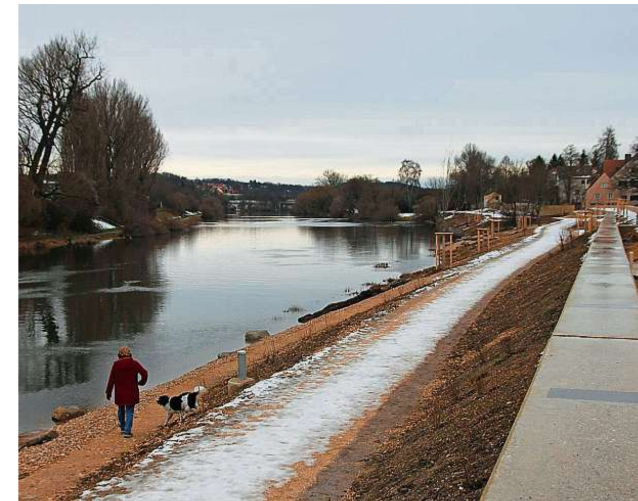
Die neu gestaltete Uferzone entlang des Regens in Reinhausen wird von Fußgängern gern genutzt. Fotos: Steffen
