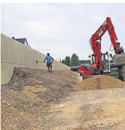
Das Gelände unterhalb der Deichmauer am Regen wird terrasiert und dient bei Hochwasser als Rückhaltefläche.
