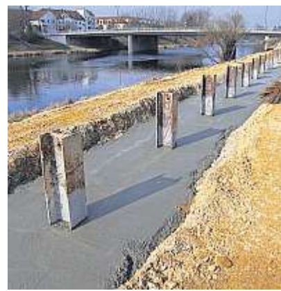
Vorbereitung für die Deichmauern in Reinhausen: 70 Zentimeter dicke Bohrpfähle reichen tief in die Erde und verankern den Beton.
