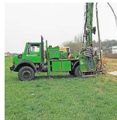
Hier in Sallern könnte der nächste Abschnitt des Hochwasserschutzes realisiert werden. Das Foto zeigt eine Probebohrung. alle Fotos: WWA
