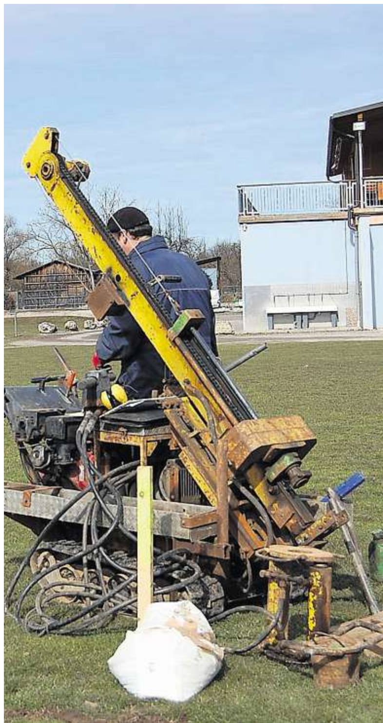
Gestern haben die Sondierungsbohrungen auf dem Gelände des SV Sallern begonnen. Ziel ist es, die Beschaffenheit des Untergrunds zu erkunden, wo der Hochwasserdamm errichtet werden soll. Foto: Scherrer
