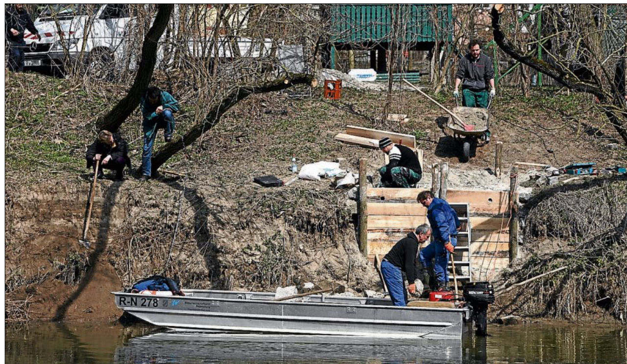
Die Bauarbeiten für die Eisvogelbruthöhlen auf der Jahninsel. Die Regensburger ornithologische Gesellschaft gab dazu den Anstoß und fachliche Tipps. (Foto: WWA)
