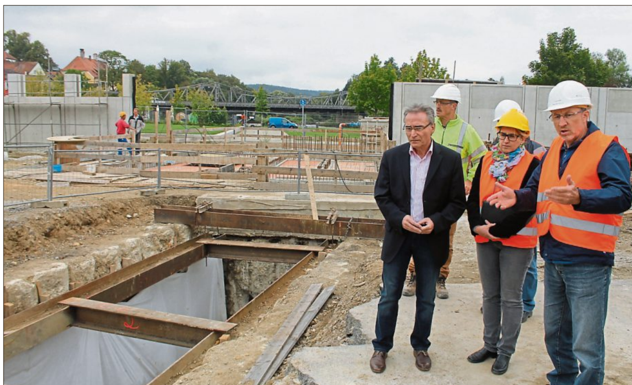
Alfons Lerch vom Wasserwirtschaftsamt Regensburg (rechts) erklärte vor Ort die aktuelle Situation der Baustelle zum Hochwasserschutz am Esper.
