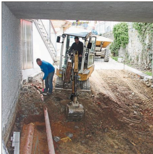
An der Fußgängerunterführung der Regenstraße entsteht derzeit das Fundament für die Fluttore.
