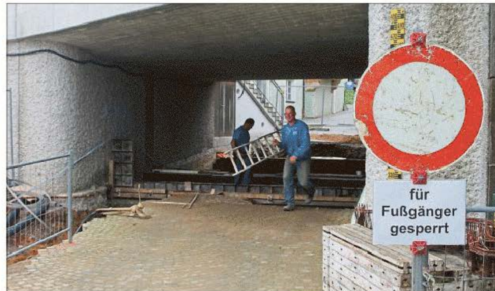
1,20 Meter dick ist das Fundament der Fluttore in der Fußgängerunterführung Regenstraße. Heute wird der Rest betoniert.
