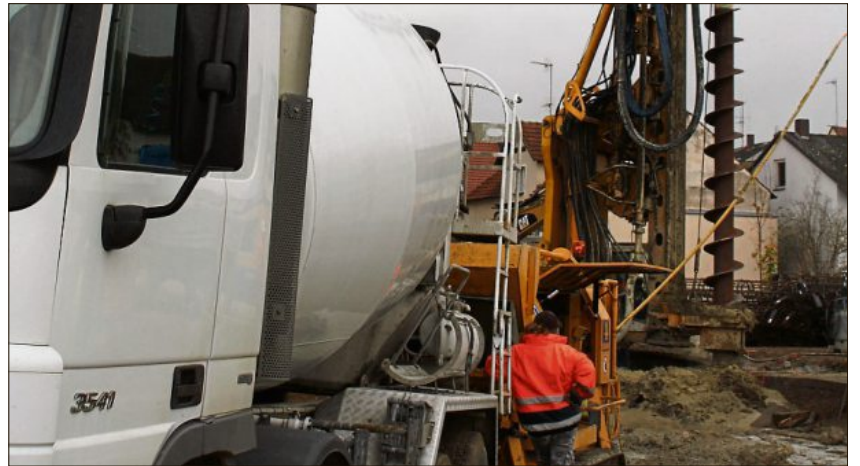
Ein Schlauch führt vom Betonmischer über den Bohrer direkt ins Bohrloch.
