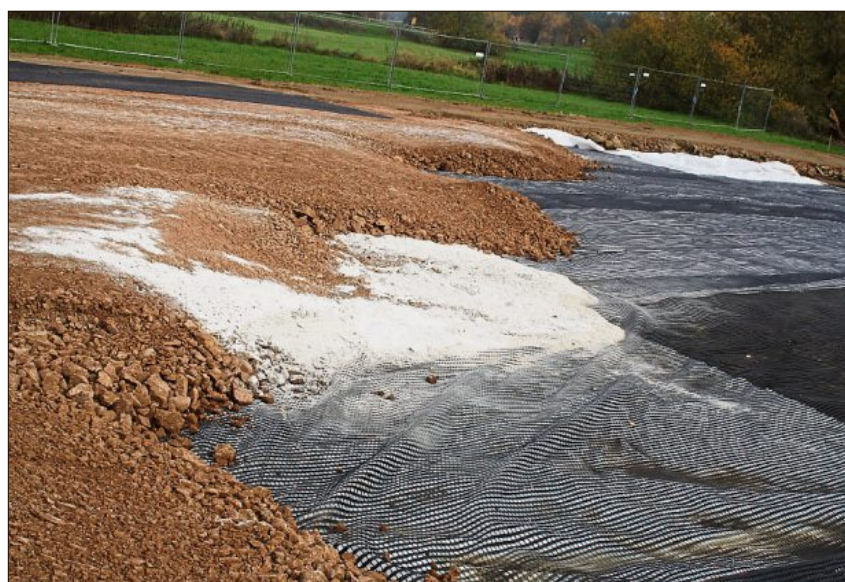
Vlies, Geogitter, spezielle Schüttungen: Der Deich entsteht.
