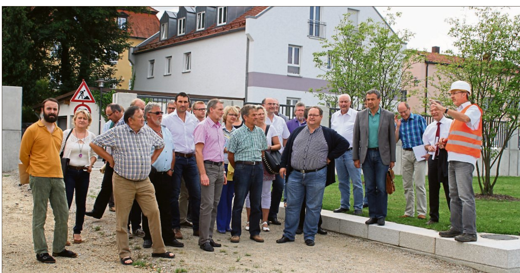
Ortstermin am Esper: Bauoberrat Alfons Lerch (rechts) führt die Räte über die Baustelle für den Rodinger Hochwasserschutz am Esper.
