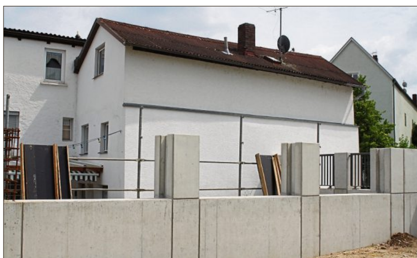
Beim Altstadtcafé wird die Schutzmauer im Bedarfsfall mit mobilen Elementen dicht gemacht.
