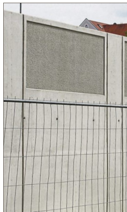
Angedeutete Fenster brechen die Höhe der Hochwasserschutzmauer.
