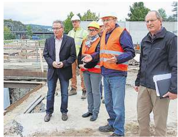
Alfons Lerch (2. v. r.) vom Wasserwirtschaftsamt erläuterte die Maßnahme.
