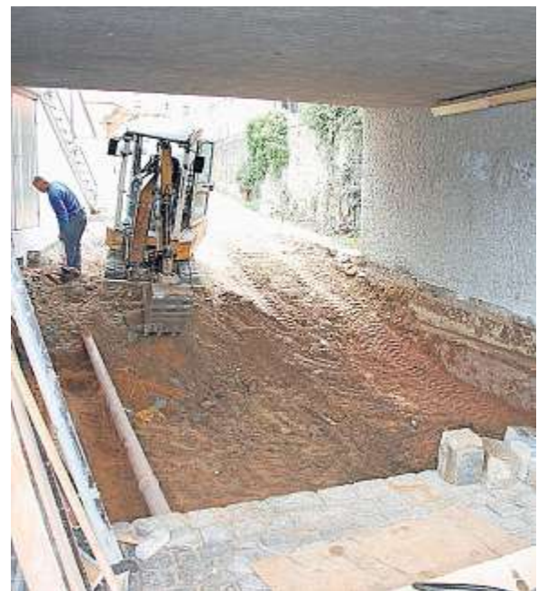
Die Fußgängerunterführung wird aufgedeckt.
