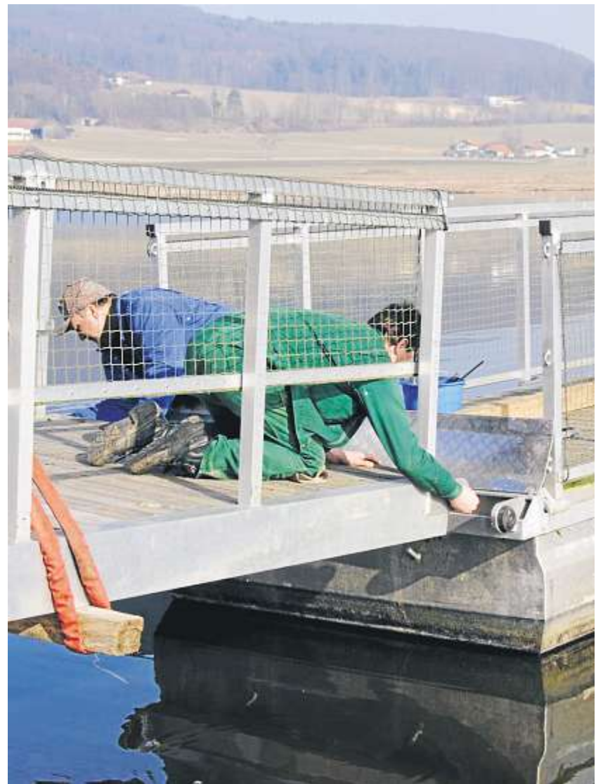
Die letzten Handgriffe zum Einbau des Schwimmstegs
