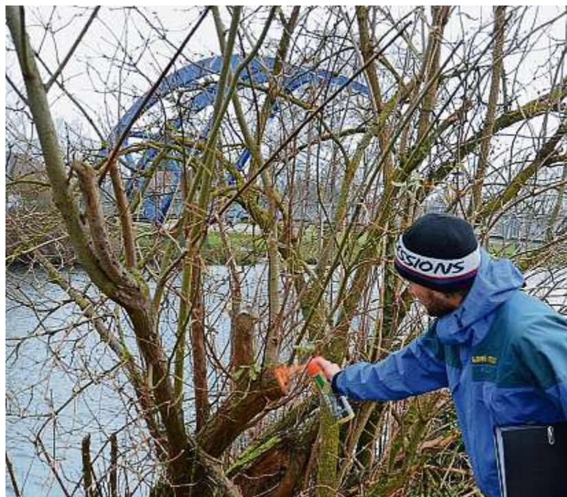
Auch die Büsche entlang des Regenufers müssen weg und werden nach Abschluss der Bauarbeiten nachgepflanzt.
