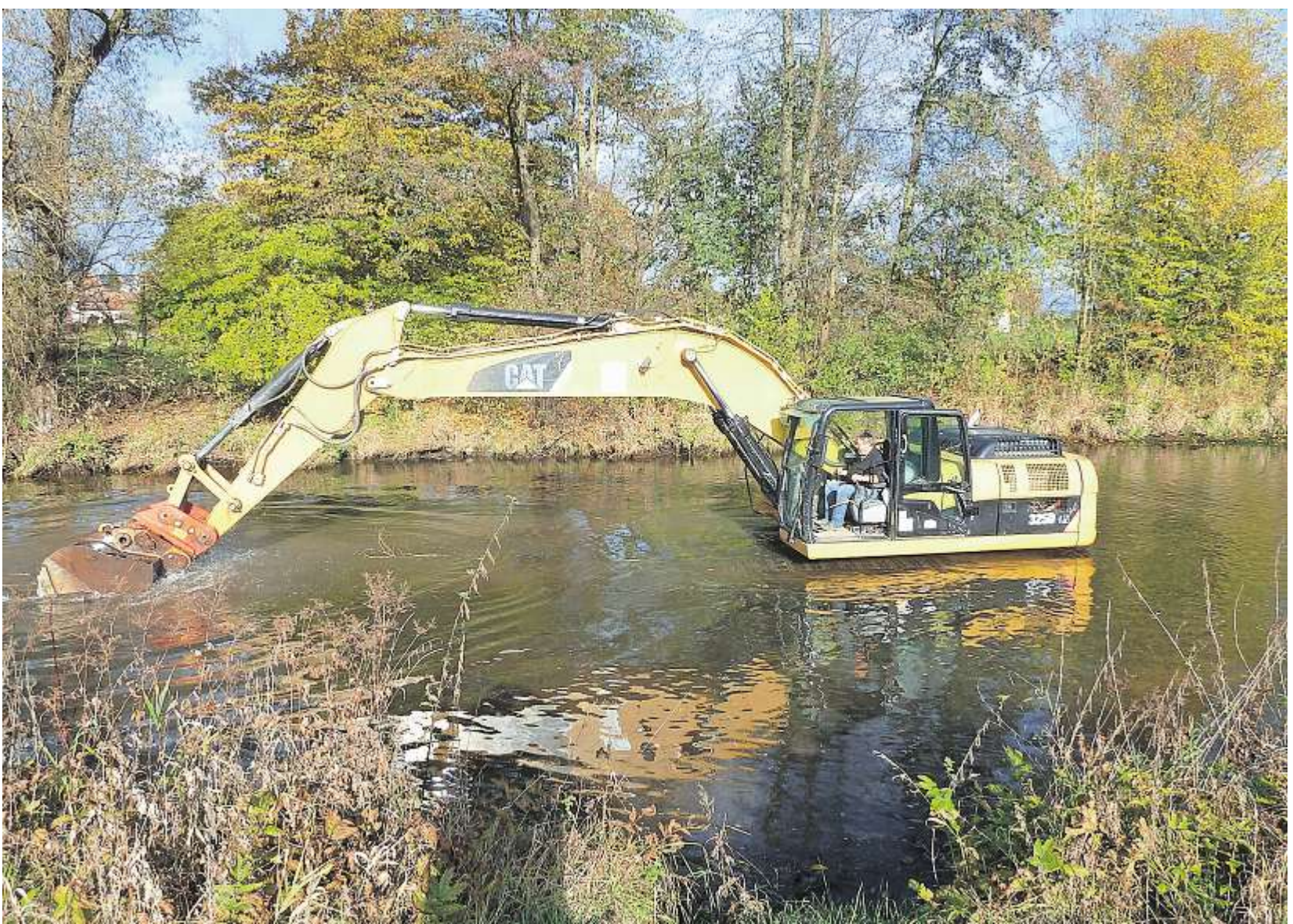
Der Bagger macht die Schwarzach wieder durchgängiger. Dazu werden Kies und Steine ins Flussbett eingebaut.
