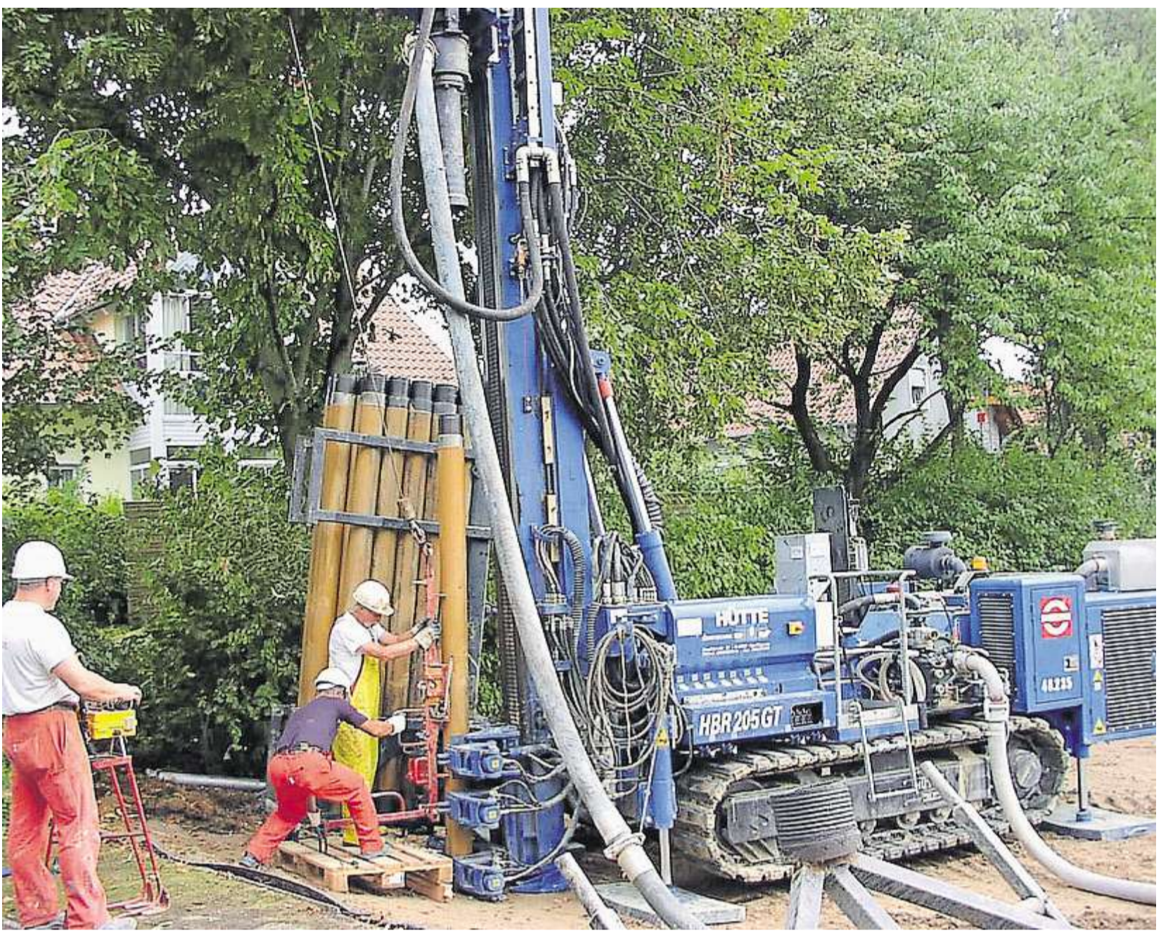
Das Wasserwirtschaftsamt Regensburg lässt im Bereich der geplanten Flutpolder Eltheim und Wörthhof insgesamt 27 neue Grundwassermessstellen einrichten. Dazu kommen vier Erkundungsbohrungen. Foto: MZ-Archiv/Thomann
