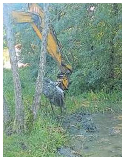
Ein Bagger schaufelt das angeschwemmte Sediment aus der Laber.
