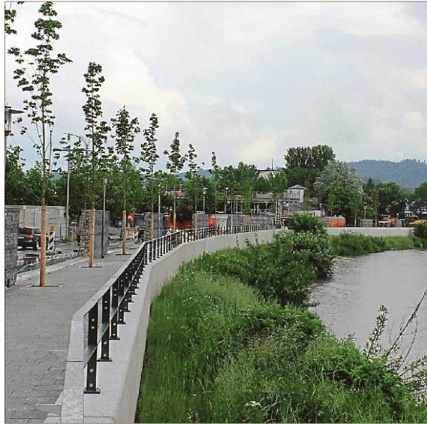
Rein optisch sehen die Hochwasserbauten schon fertig aus. Doch wirklich schützen können sie Cham noch nicht.
