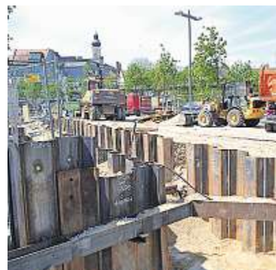
Die Fertigstellung am Floßhafen dauert wohl noch bis September.
