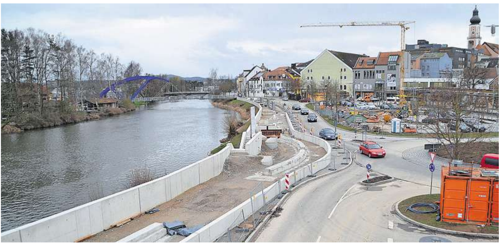
Die Mauer steht, doch noch hat sie keine Wirkung. Erst wenn das Schöpfwerk in der Mitte des Floßhafens in Betrieb ist.
