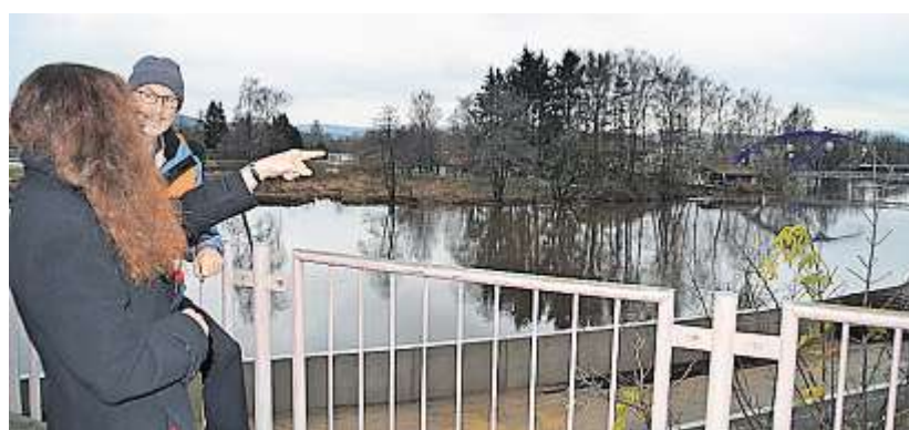
Alfons Lerch und Bürgermeisterin Karin Bucher bei der Baustellenbesichtigung am Mittwoch
