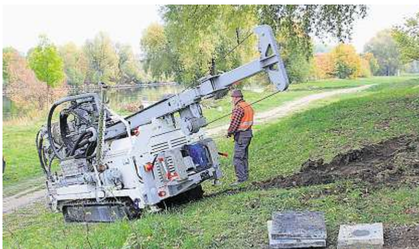
Die Bohrfahrzeuge sind auf Ketten gelagert.
