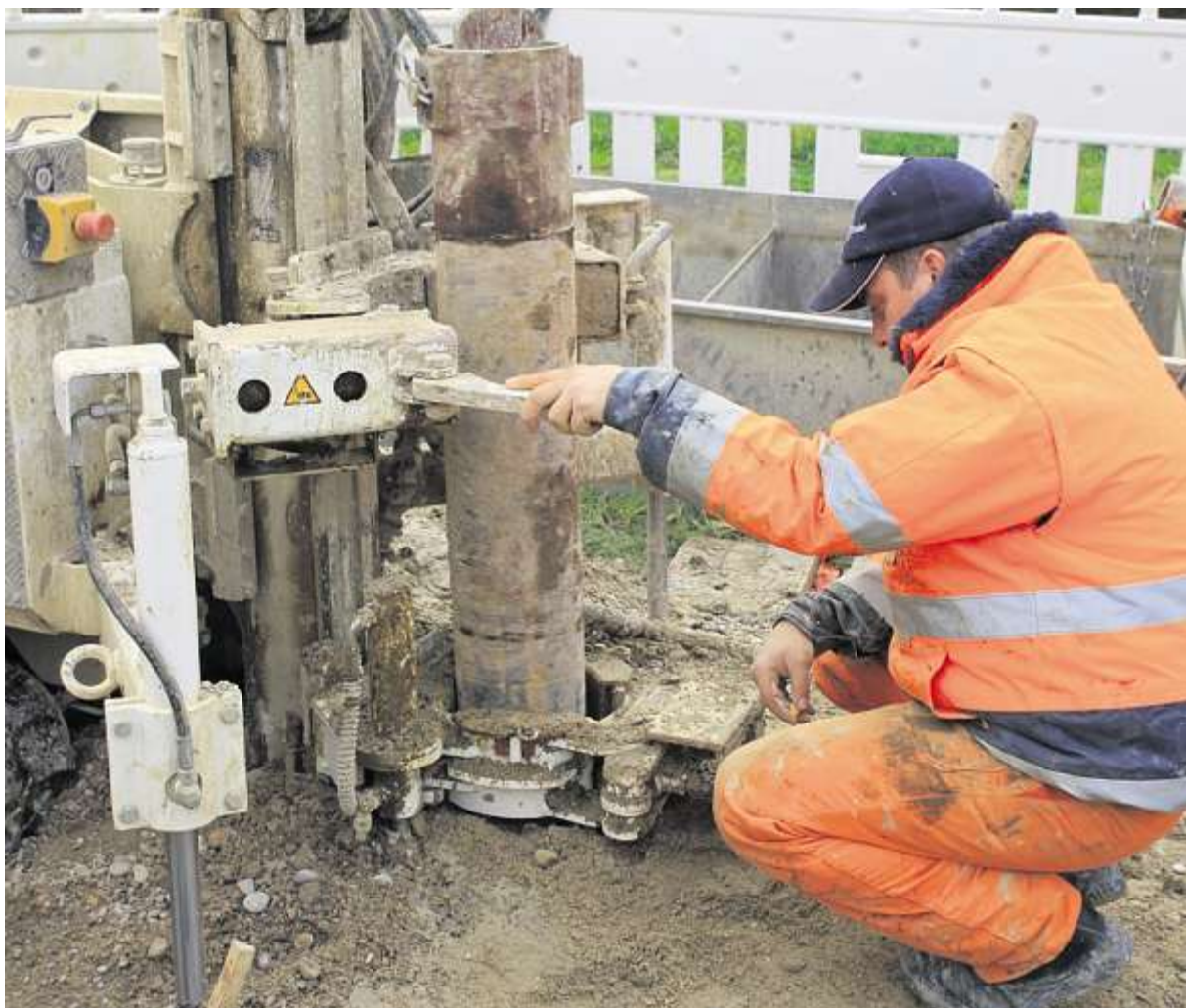
Das Wasserwirtschaftsamt führt am Unteren Wöhrd derzeit eine Baugrunduntersuchung durch. Die Bohrer winden sich zwischen 20 und 35 Meter tief in die Erde. Fotos: Steffen
