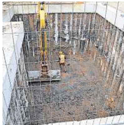
Der Bau für das Schöpfwerk am Floßhafen geht bis auf den Fels runter.
