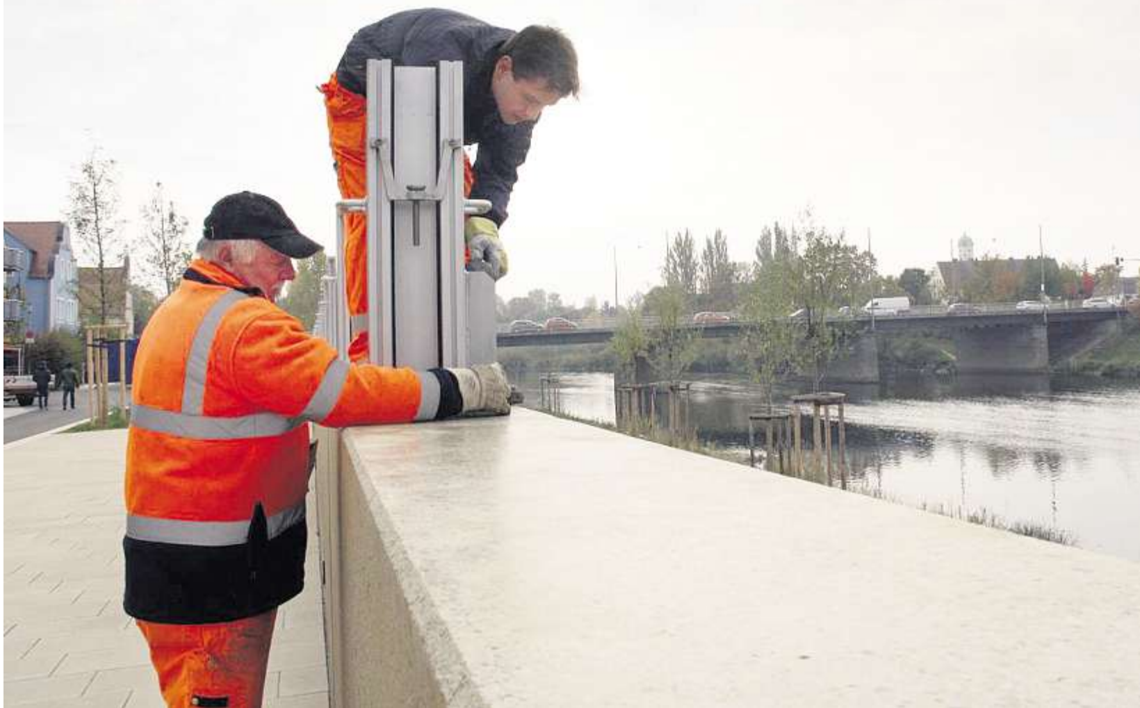
Stütze für Stütze: Der Aufbau des mobilen Hochwasserschutzes, den Stadtmitarbeiter gestern probten, ist aufwendig.
