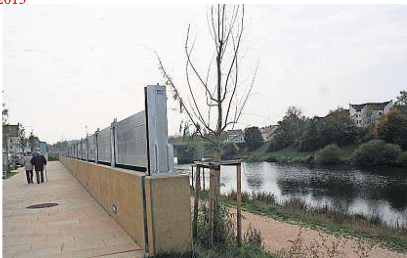
Auf einer Strecke von 600 Metern, zwischen Uferstraße und Frankenbrücke, war die Betonmauer am Dienstag mit Alu aufgestockt.
