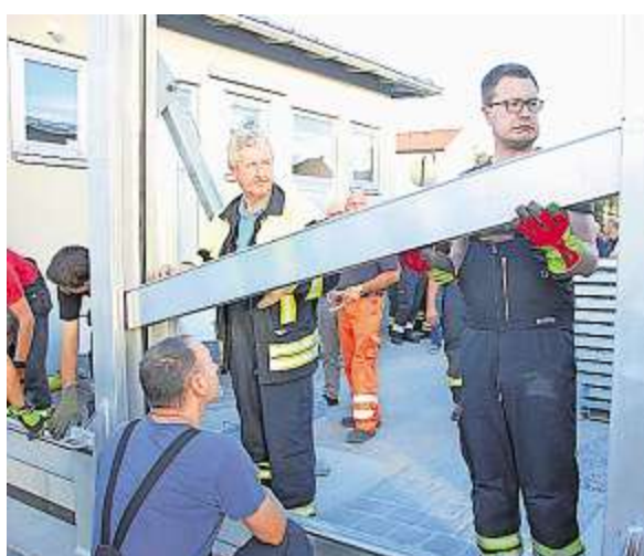
Die Dämmelemente werden eingefügt.
