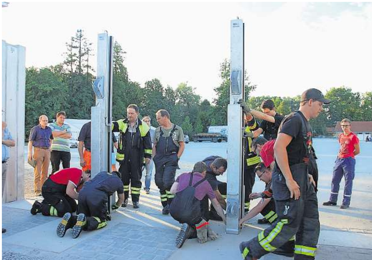
Am Eingang zum Volksfestplatz werden im Hochwasserfall zunächst zwei stehende Säulen eingebaut, zwischen ihnen sowie der festen Hochwassermauer werden die Dämmelemente eingefügt.
