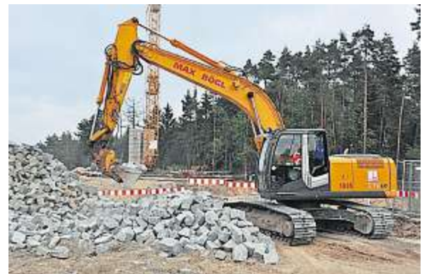
Mit Granitsteinen wird das Kanalbett seitlich befestigt.
