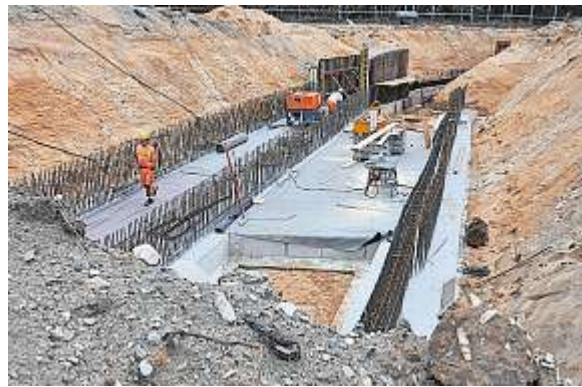
Die Bodenplatte ist schon drin.
