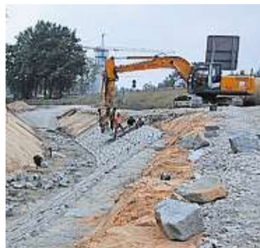
Aktuell werden bereits Teile des Kanalbetts mit Steinen ausgelegt.
