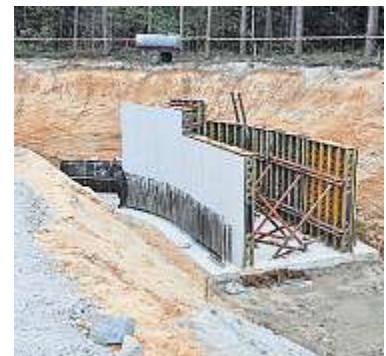
Auf der Baustelle geht alles zügig voran.
