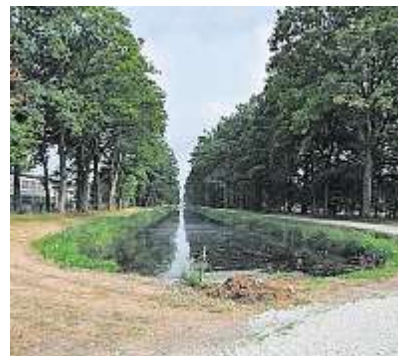
Der Ludwig-Main-Donau-Kanal nördlich der Baustelle an der B 299
