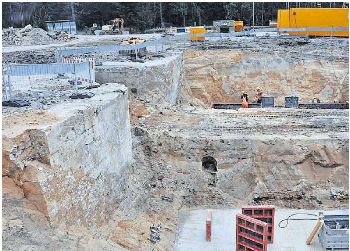
Teilweise ist die bald 200 Jahre alte Schleuse 31 des Alten Kanals bei Schliererhaide bereits ausgegraben. Die vielen Jahrzehnte haben ihre Spuren am historischen Bauwerk hinterlassen.
