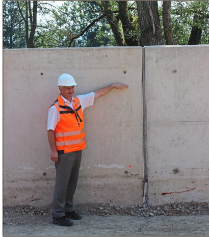
Ingenieur Johannes Posel zeigt, welcher Mauerabsatz sichtbar bleibt.
