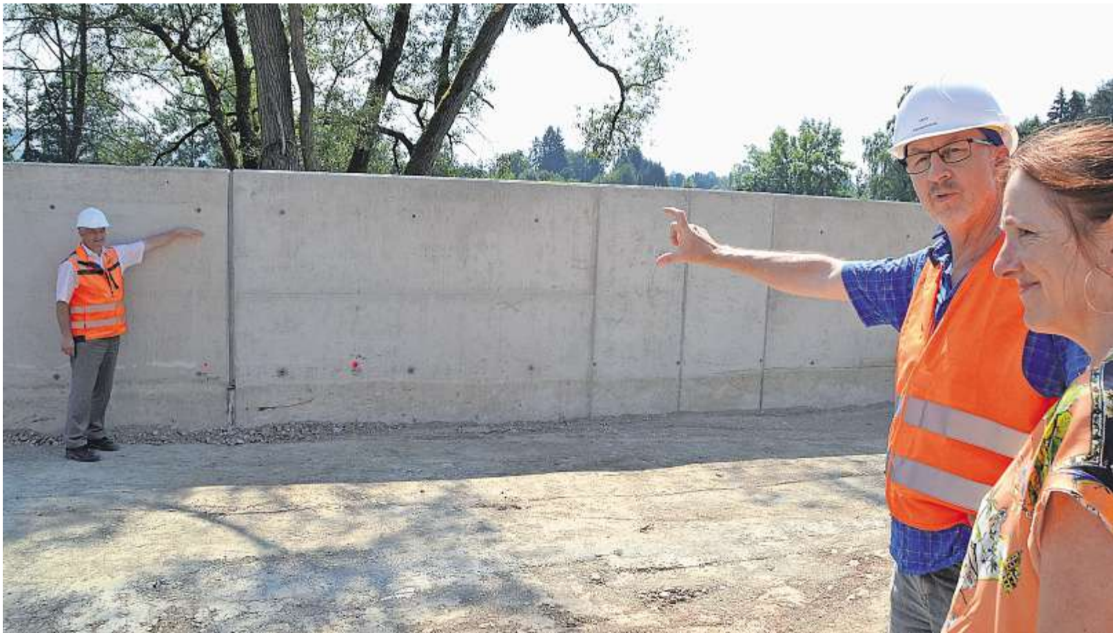
Ingenieur Johann Posel (li.) zeigt's an, was von der Mauer am Ende zu sehen sein wird, während Alfons Lerch vom Wasserwirtschaftsamt mit den Fingern der rechten Hand etwas untertreibt. 40 Zentimeter bleiben sichtbar. Rundherum wird begrünt und werden teilweise Gabionen aufgestellt. Fotos: Klöckner
