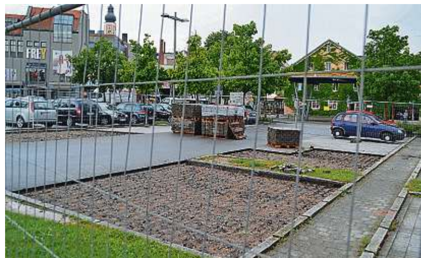
Es geht ans Eingemachte: ein großer Teil des Floßhafen-Parkplatzes ist mittlerweile abgesperrt. Erste Bauarbeiten und Sondierungen nach Kriegsmüll haben begonnen.
