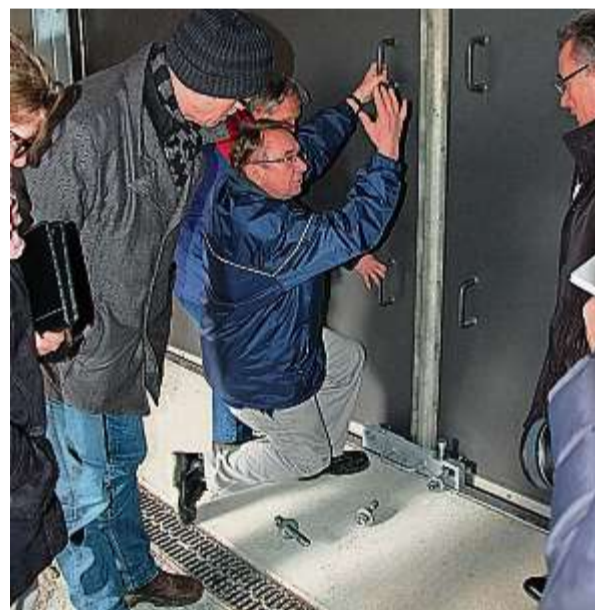
Mit einem Spezialverschluss werden die beiden Torflügel arretiert.
