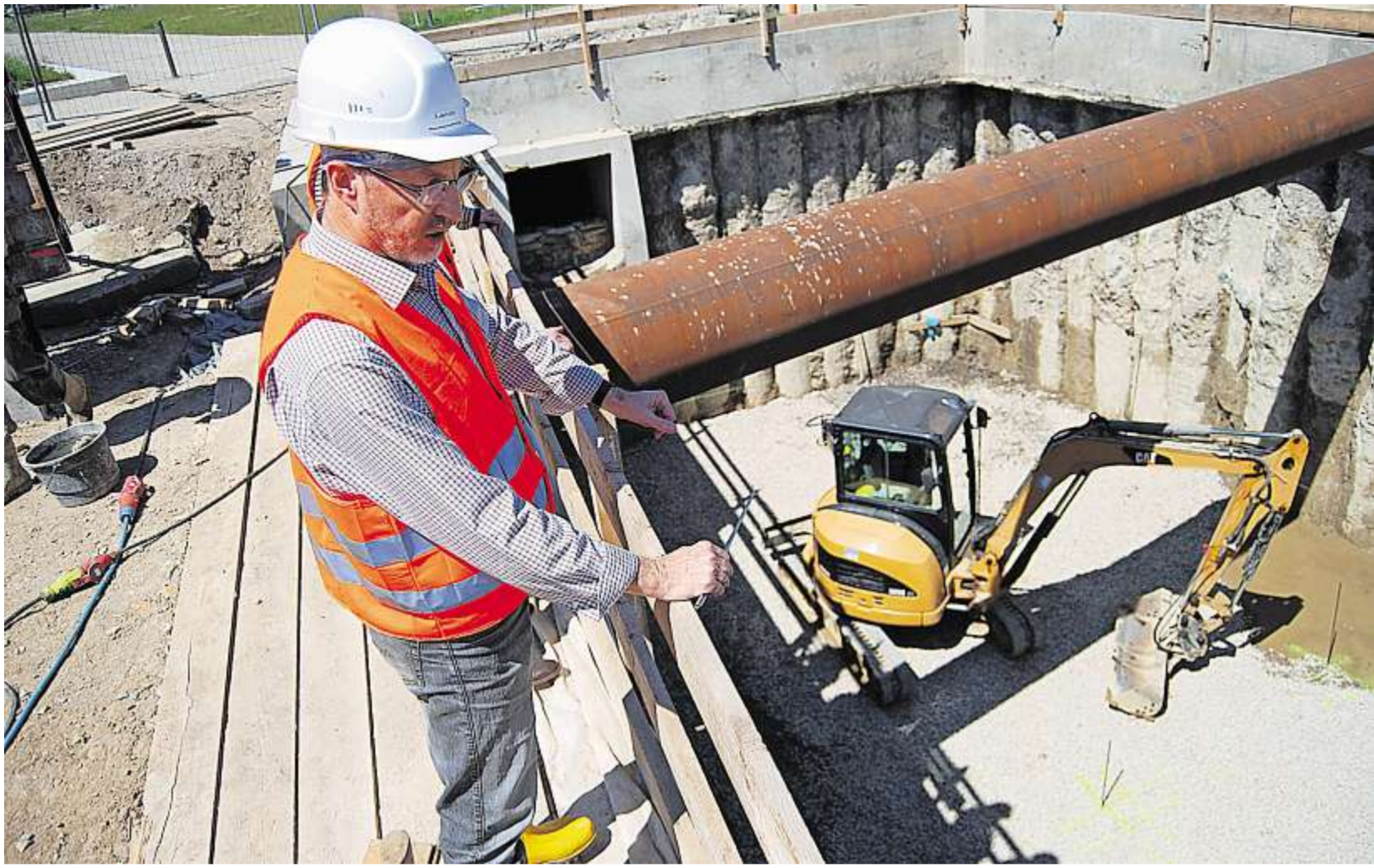
Alfons Lerch vom Wasserwirtschaftsamt Regensburg kommt gern in die Stadt an der Regen Reib'n. Mit Sicht auf den Rodinger Hochwasserschutz – hier die gigantische Baugrube für das große Pumpwerk nahe des Volksfestplatzes – blickt er beileibe nicht in einen gähnenden Abgrund, sondern durchaus in eine rosige Zukunft, die den Rodingern am Regen schon ab Ende dieses Jahres endlich umfassend Sicherheit vor Fluten bieten wird. Fotos: R. Schlecht
