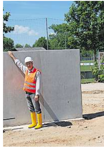
An dieser Stelle am Fußballplatz endet die Mauer. Es beginnt der Deich, der noch aufgewallt werden muss.
