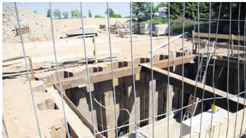
Das zweite und kleinere Pumpwerk unweit der B 85 ist im Bau befindlich und durch einen Zaun gut gesichert. Im Hintergrund ist schon der Deich, dessen Krone einmal zum Teil auf vier Metern Höhe angesiedelt wird.
