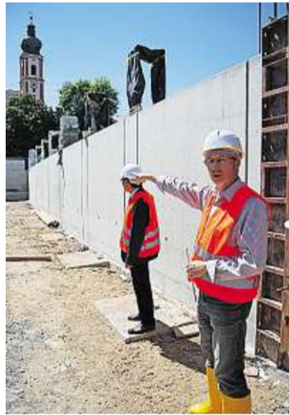
Alfons Lerch und Franz Reichold begutachten nahe der Regenstraße die Hochwasser-Mauern.
