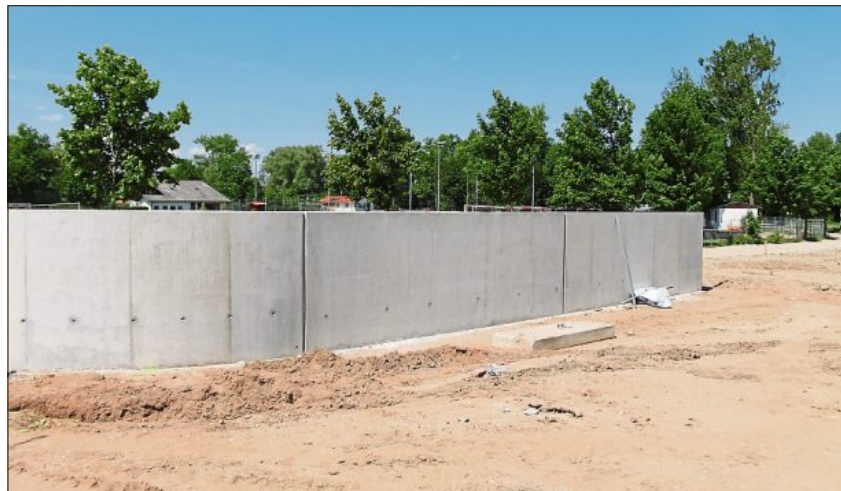
In diesem Bereich wird der Damm an die schon fertige Mauer anschließen.
