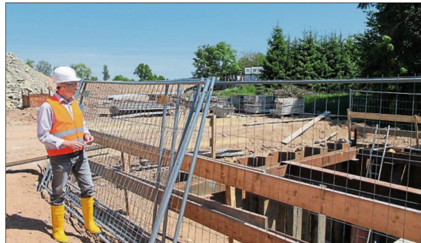
Hier entsteht das Schöpfwerk II beim Hochwasserschutzdeich.
