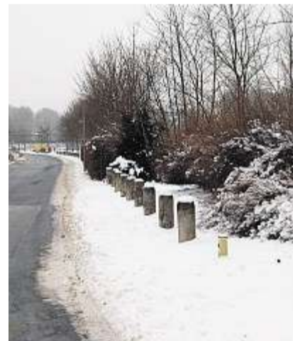
Zwischen Jahnstraße und Fußballplatz wird eine Mauer errichtet.
