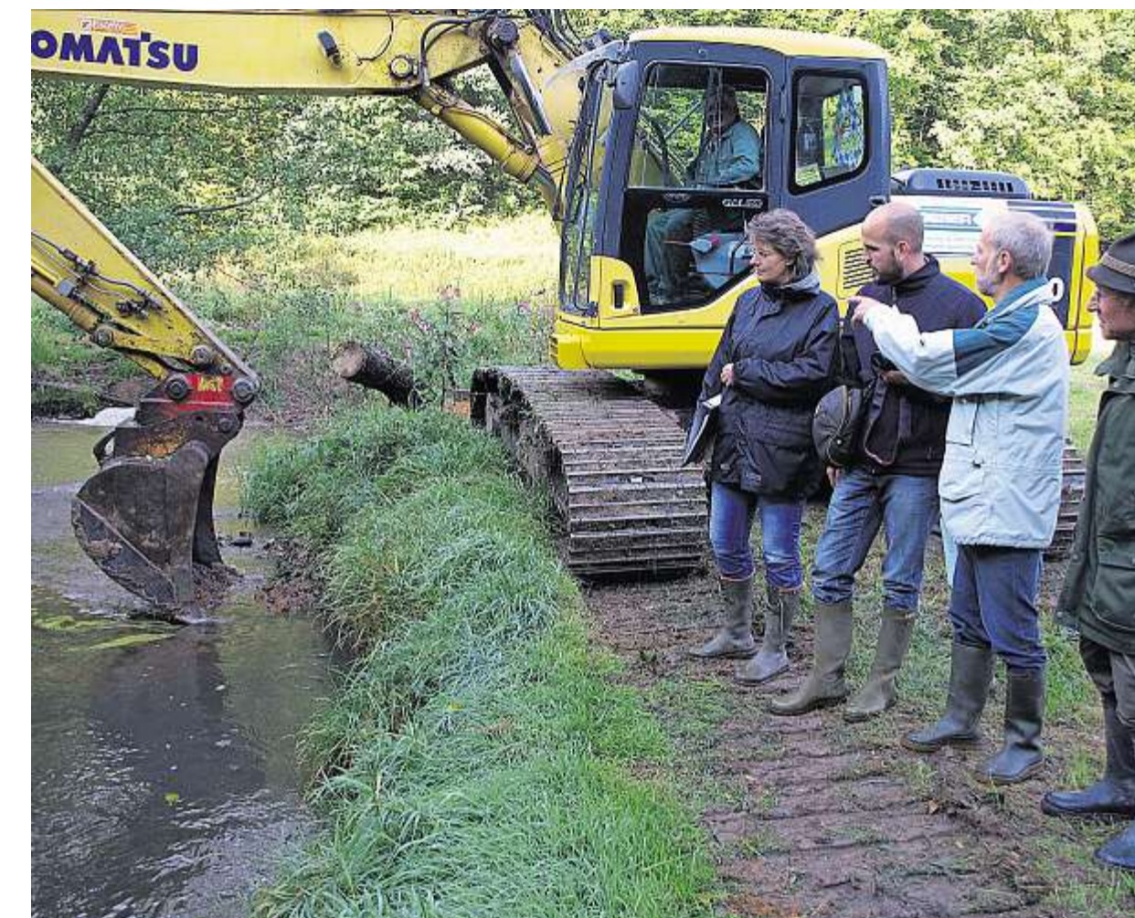
Die Baggerarbeiten des Wasserwirtschaftsamts am Otterbach sind der erste Einsatz für die Maßnahme zur Umsetzung der EU-Wasserrahmenrichtlinie, die insgesamt bis im Jahr 2015 abgeschlossen sein soll. Foto: Luft
