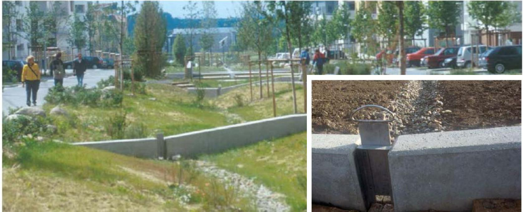
Abb. 46: Multifunktionale Gestaltung einer Allee mit Retentionskaskade
