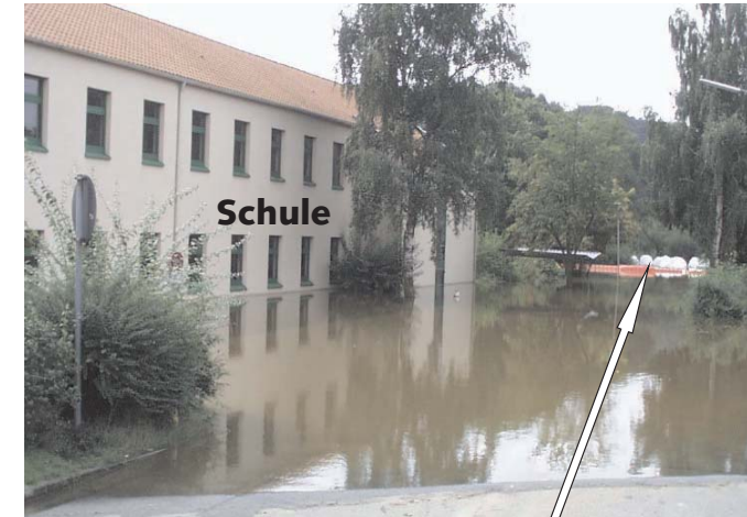
Hochwasser 2002 provisorischer Eigenschutz hat versagt
