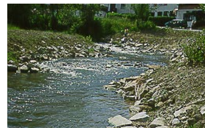
▲ Die neue Sohlrampe ersetzt die alte Stauanlage mit Triebwerk. Wasserorganismen können hier inzwischen problemlos vom Regen in den Klinglbach einwandern.
