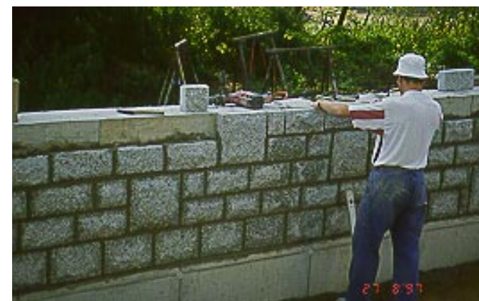
▲ Sichtmauerwerk am Klinglbach. Die Verblendung erfolgte mit naturraumbezogenen Granitsteinen im unregelmäßigen Verbund.
