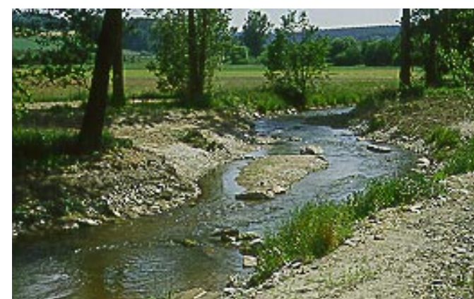
▲ Ein besonderes Augenmerk galt dem neuen Gewässerbett, das schon kurz nach der Ausführung einen sehr natürlichen Eindruck vermittelte.
