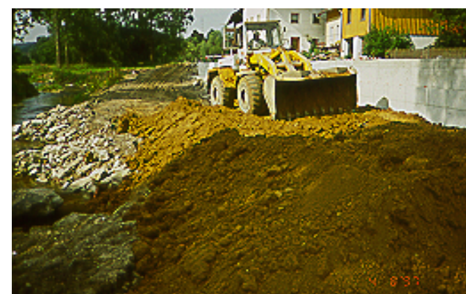
▲ Technische Schutzbauwerke, wie Schöpfwerke, Rückhaltebecken und Schutzmauern wurden mit viel Einfühlungsvermögen in die örtliche Umgebung eingebunden. Hochwasserschutz-Mauern wirken durch gezielte Vorschüttungen recht unscheinbar.
